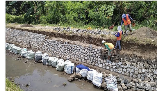
PASANGAN BATU BEKAS BONGKARAN
