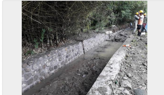
PASANGAN BATU BEKAS BONGKARAN
