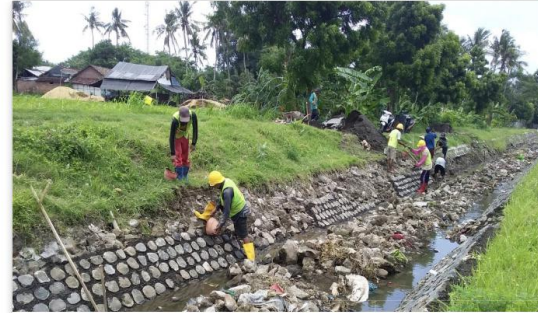
Pasangan Batu Bekas Bongkaran
